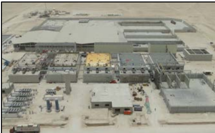
Doha (Qatar) 15 digesters for 301'400 t/y (OFMSW & SSO)
